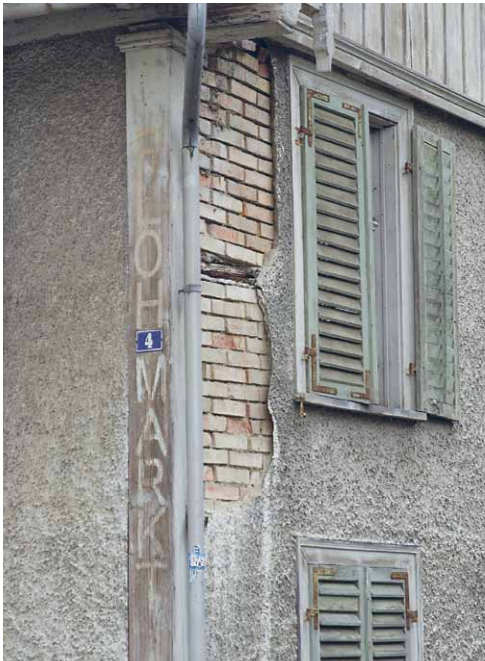
FASSADE VOR DER RENOVATION
