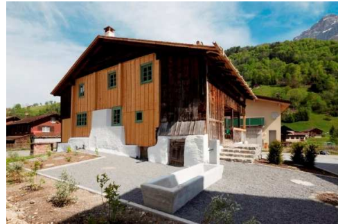
Südfassade nach Renovation
