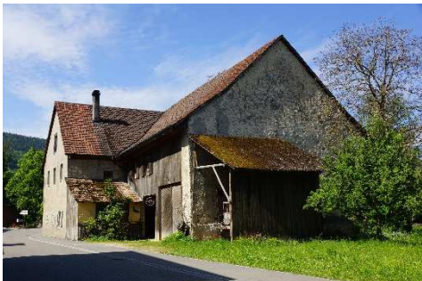
Flederhaus in Wegenstetten © Ferien im Baudenkmal
