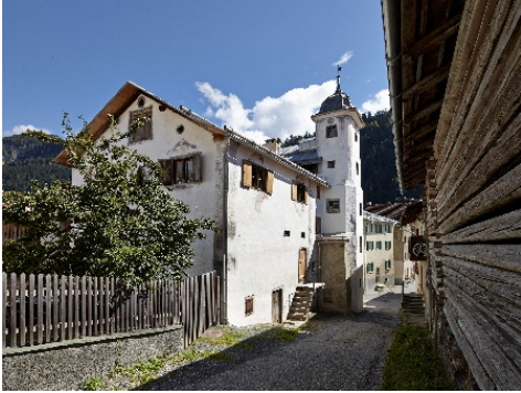
Turalihus Aussenansicht Rückseite © Für Ferien im Baudenkmal Gataric Fotografie
