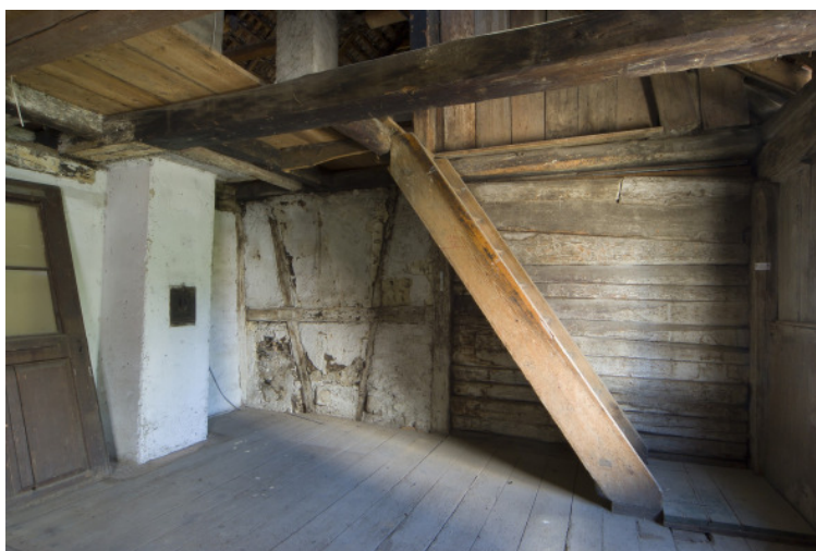
Das Innere der Fischerhäuser während der Renovation. (Foto: Denkmalpflege Thurgau)
