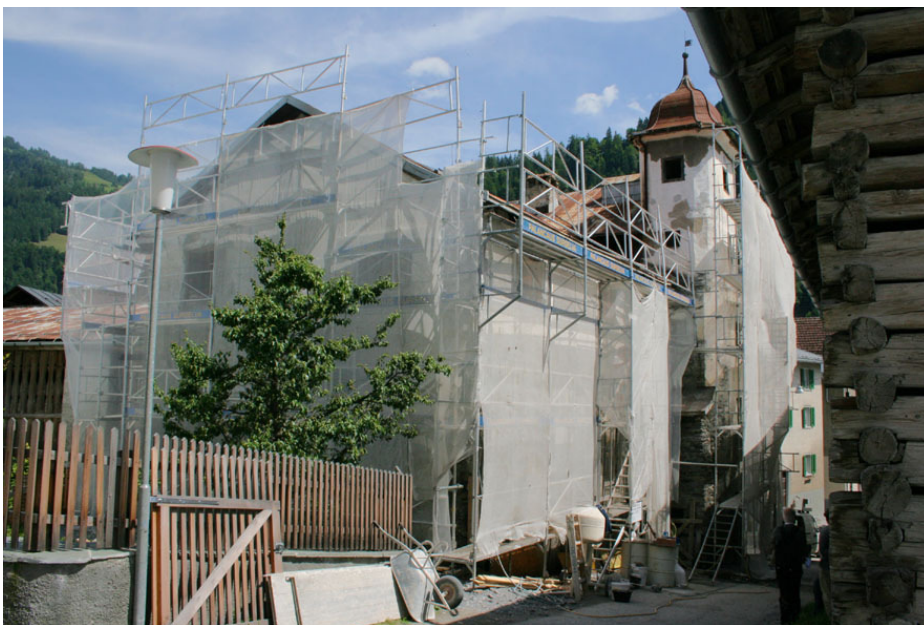
Das eingerüstete Türalihus in Valendas GR. Die Stiftung Ferien im Baudenkmal renoviert in einer ersten Etappe die Fassaden und das Dach. Später werden darin zwei aussergewöhnliche Ferienwohnungen in historischen Räumen angeboten. (Foto SHS)
