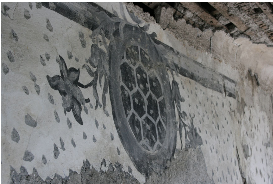
Unter dem Verputz ist direkt unter dem Dach diese schöne Fassadenmalerei gefunden worden. Sie stellt als Ergänzung zu den zwei echten Öffnungen ein „Putzenscheiben-Fenster“ dar. (Foto SHS)
