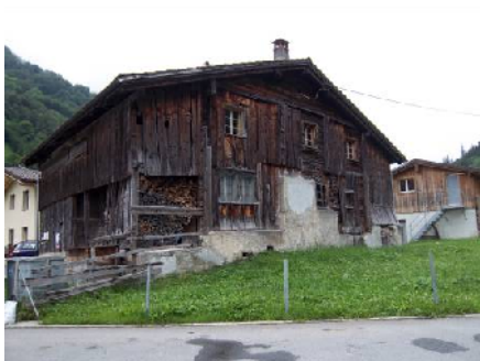
Stüssihofstatt in Unterschächen UR vor Renovation
