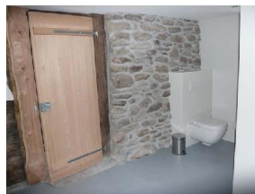
Neue Sanitäreinrichtungen Nouveaux sanitaires
