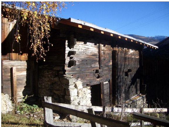
Das Huberhaus vor der Renovation im Herbst 2006. La Huberhaus avant la rénovation en automne 2006
