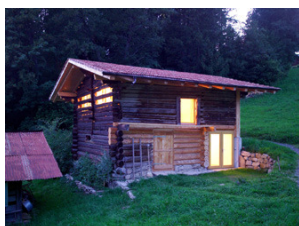
Scheune mit neuen Balken La grange avec ses parties neuves
