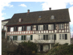
Das Haus „Blumenhalde“ befindet sich am Zürichsee
