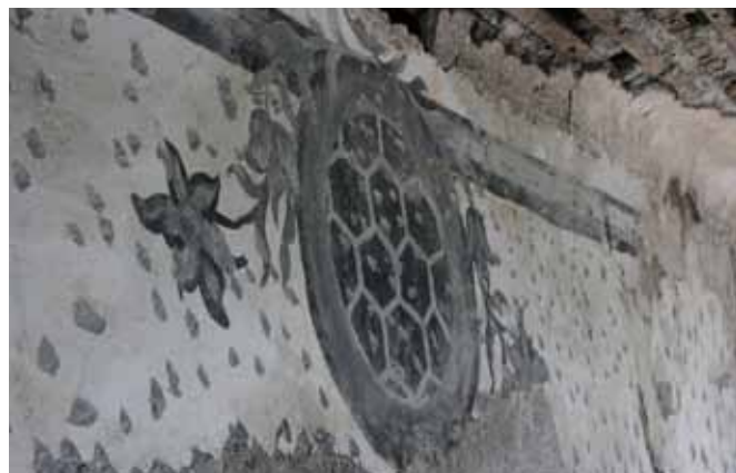
Das „Butzenscheibenfenster“ auf der strassenseitigen Fassade. „Fenêtre en culs de bouteille“ sur la façade côté rue.
