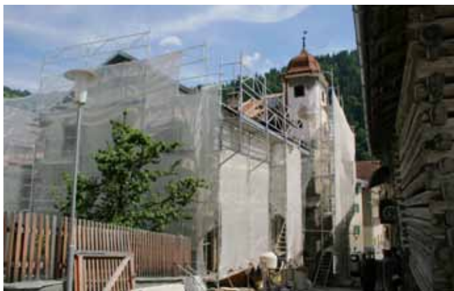
Seit Juni 2010 ist das Turalihus in Valendas eingerüstet Depuis juin 2010, la Turalihaus disparaît sous les échafaudages
